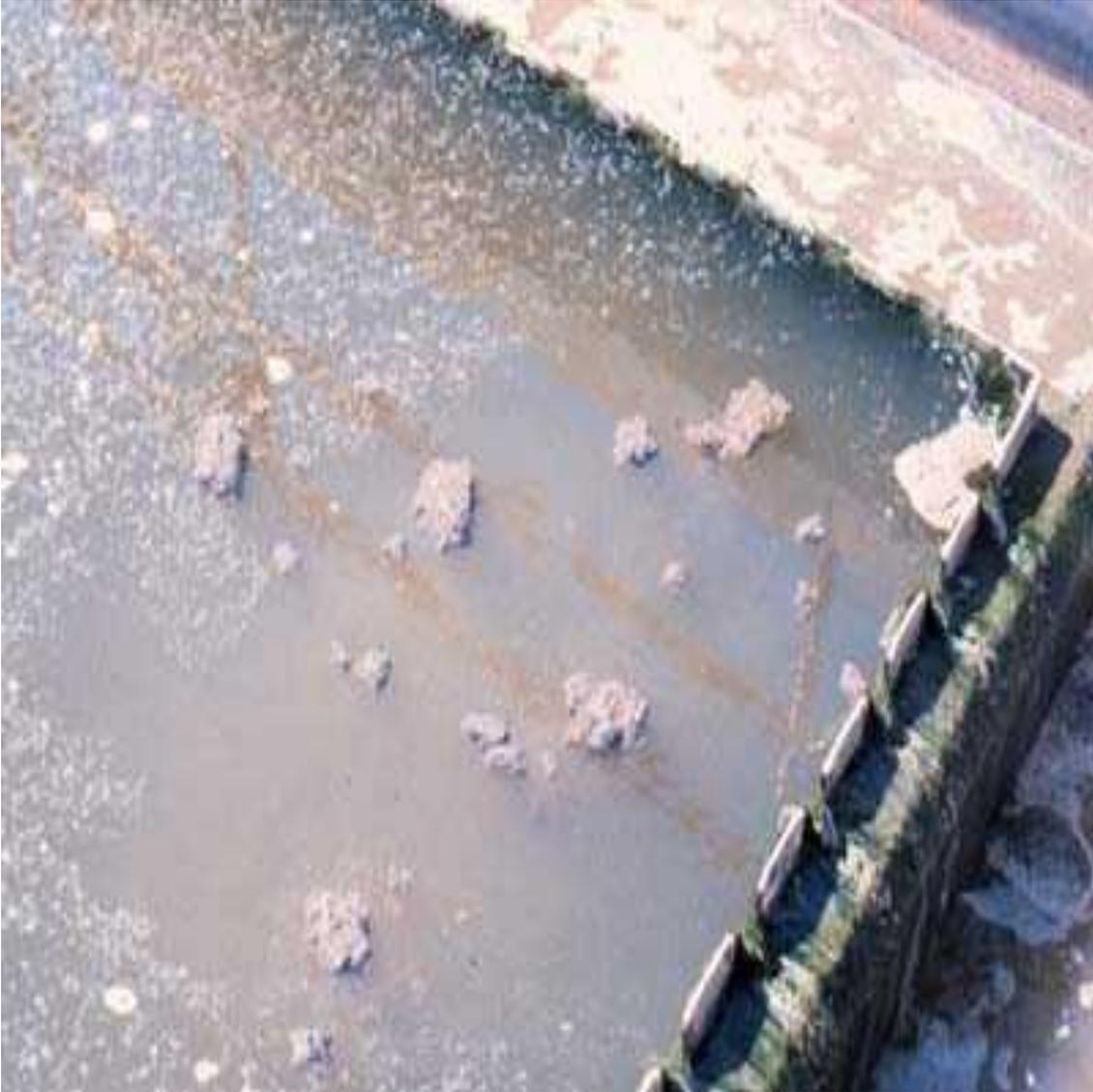
شكل رقم (٥-٧) وجود فقاعات غاز النيتروجين بالحمأة وطفوها على السطح
